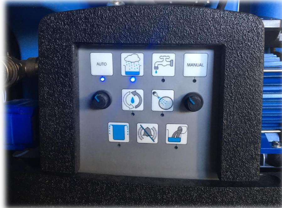
Auf dem Durchflußwächter des IRM-Wassermanager ist der tatsächliche Druck des Systems angegeben. Auf dem Bedienfeld der IRM-Steuerung kann der aktuelle Betriebszustand abgelesen werden. In diesem Beispiel befindet sich der Wassermanager im Automatikbetrieb und verwendet Regenwasser. Darüber hinaus kann man auf dem Bedienfeld die automatische Filterreinigung sowie den Stagnationsschutz einstellen.
