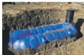
Neoline kunststof regenwatertank die grondwaterbestendig is. Leverbaar van 800 tot 50.000 liter. Deze tank is slechts 126 cm diep, dus eenvoudig in te graven.
