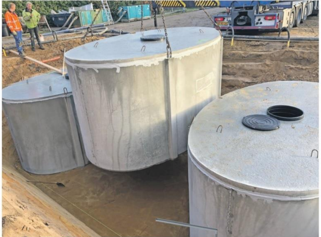
Varitank regenwaterput van beton wordt geplaatst.
