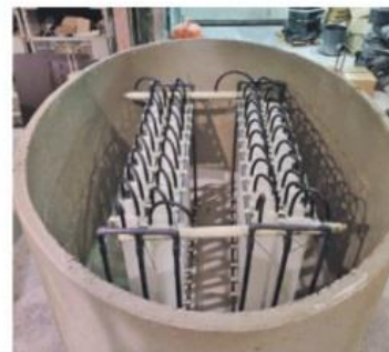
Opvang van regenwater is ook te combineren met thermische energieopslag. Het systeem omvat een regenwaterput met warmtewisselaar en standaard acht PVT panelen op het dak.
