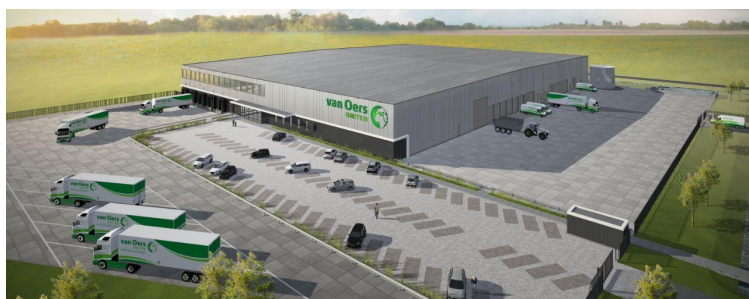
Van Oers Dinteloord, kantoor met distributiecentrum
