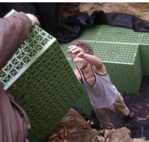
Het plaatsen van de infiltratiekratten.
