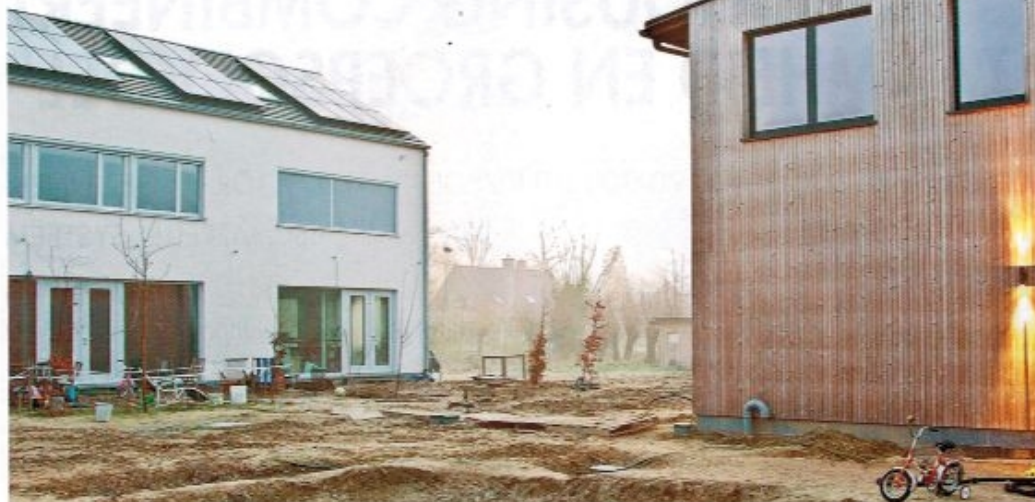
Duurzaamheid staat centraal bij cohousing. Van de in totaal zeventien woningen hebben elf het nulenergiecertificaat behaald. De zeven andere woningen zijn lage-energie woningen. Alle daken op de huizen liggen vol zonnepanelen
