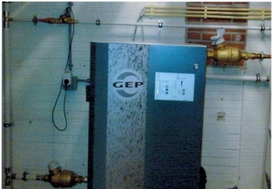
Regenwassermodul mit Trinkwassernachspeisung im Technikraum
