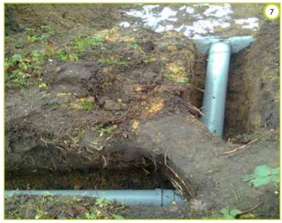
Abflussrohre vom Anschluss des Versickerungsrohrs mit Adapter zu den GEP Matrix Boxen
