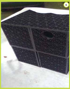
Einsetzen und mit Geotextil umwickeln der GEP Matrix Boxen
