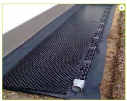
Verlegen der GEP 30 mm Versickerungsplatten und des Versickerungsrohr auf der Oberseite der zuvor ausgelegten wasserdichten Folie
