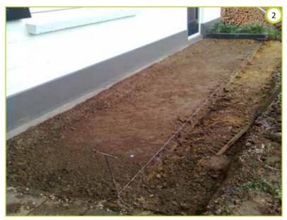
Aushub für ein separates GEP Versickerungsrohr zur schnellen Entwässerung
