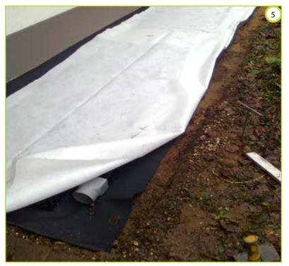
Überdecken bzw. einfassen der GEP Versickerungsplatten und der Versickerungsrohre mit Geotextil
