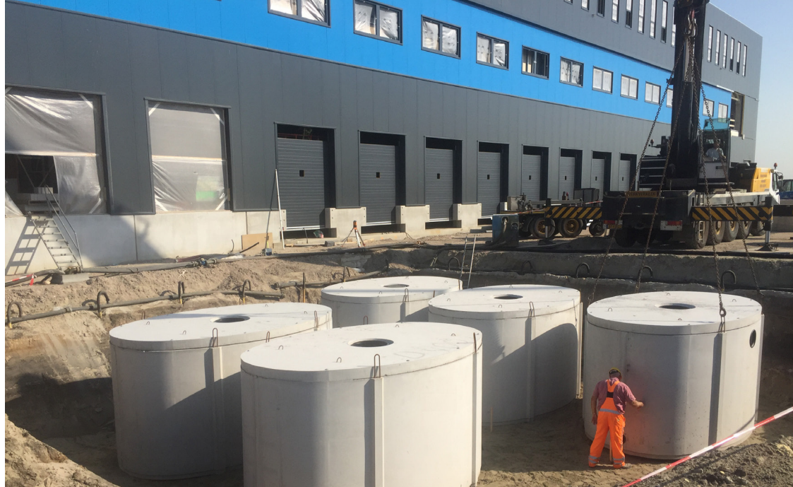
Vijf putten van beton elk 20 m 3 , zijn onderling als communicerend vat gekoppeld, zwaar verkeer bestendig uitgevoerd.
